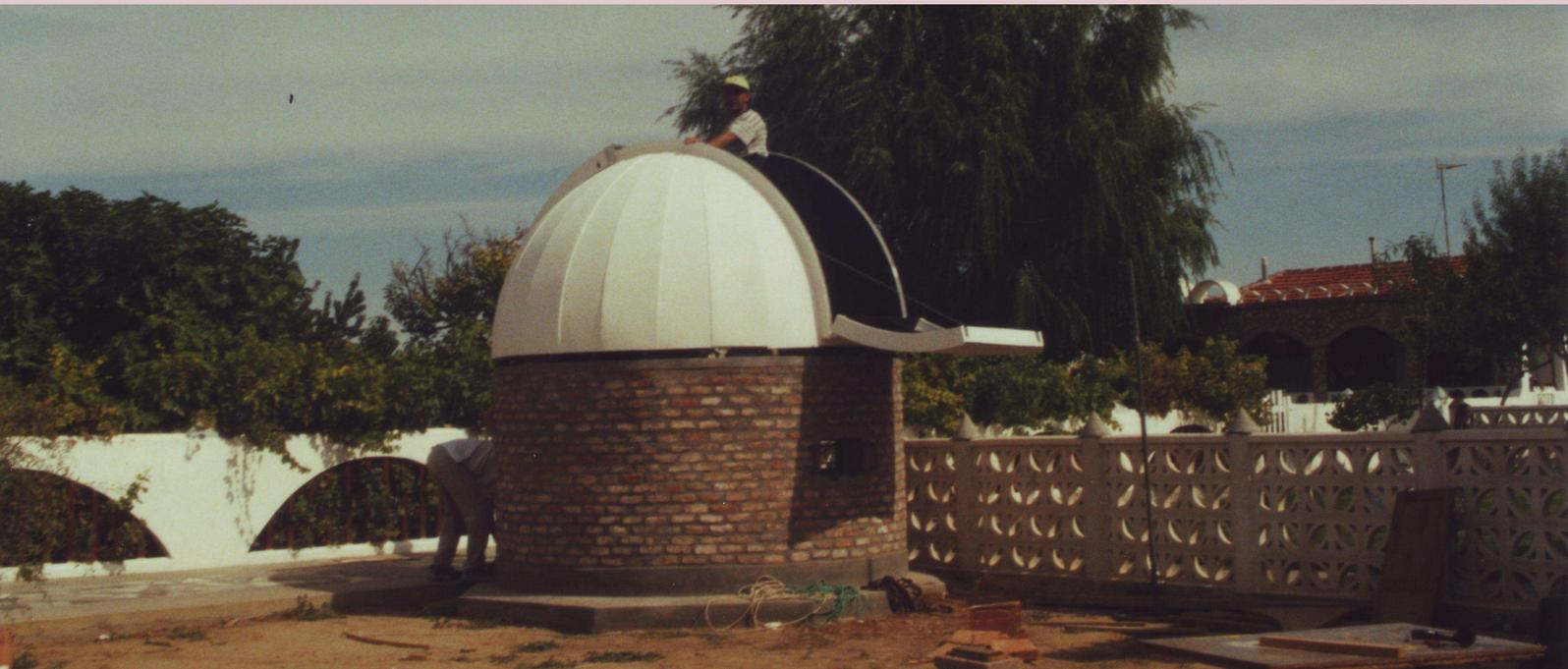
Las obras de construcción del OACP culminándose. Ensamblado de la cúpula.
