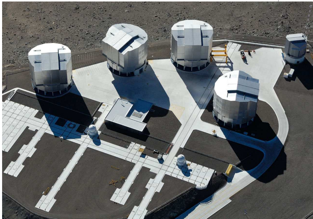
Figura 7. El Very Large Telescope (VLT), el telescopio muy grande. Es un sistema de cuatro telescopios ópticos separados, rodeados por varios instrumentos menores. Cada uno de los cuatro instrumentos principales es un telescopio reflector con un espejo de 8,2 metros. El proyecto VLT forma parte del Observatorio Europeo del Sur (ESO), la mayor organización astronómica de Europa. En esta sección son varios los trabajos que han empleado esta instalación. Fuente: Wikipedia.
